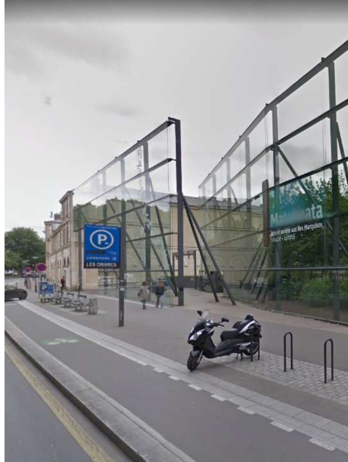
Musée du quai Branly - Paris. De hautes parois vitrées, implantées quinconce assurent à la fois perméabilités physiques et visuelles.
