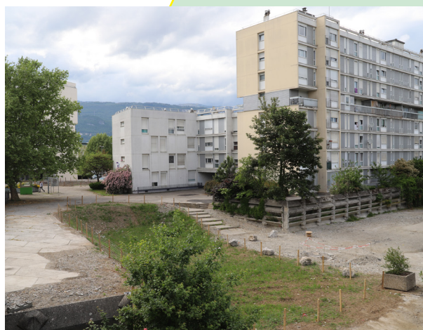
En 2023, un nouvel espace vert avec un verger en terrasse sera aménagé suite à la démolition des 22 logements du 2 Ouessant.
