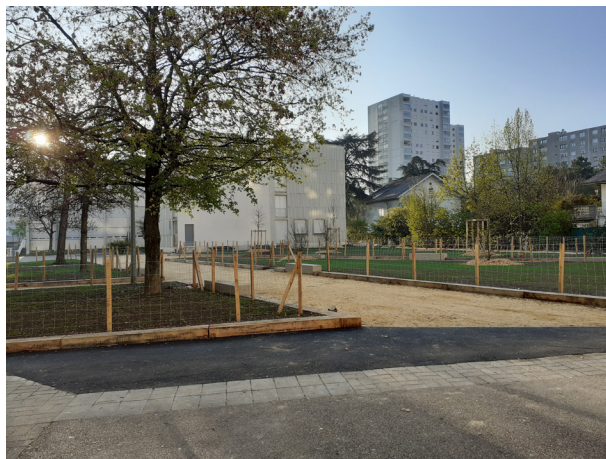
Suite à la démolition, les abords du Gâtinais aménagés.
