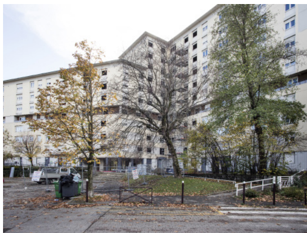
Le Limousin avant la démolition du 7-9.
